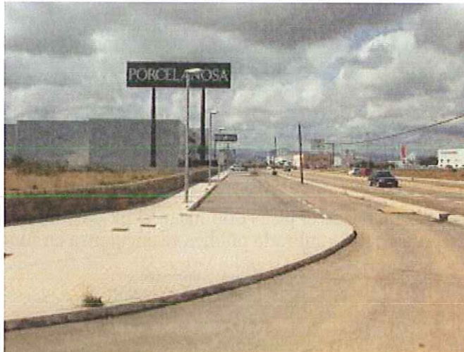
Foto 8: Vial de servicio (pk 3+040 sentido Onda)
