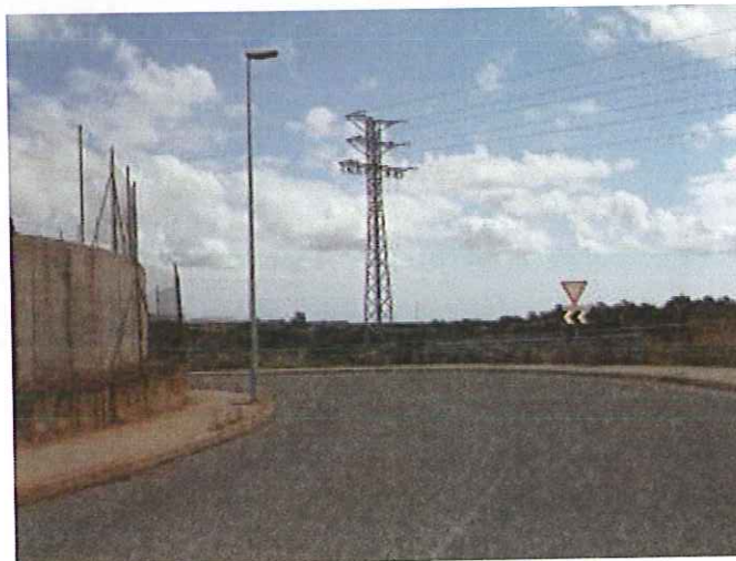
Foto 16: Primer doble circuito desde ST Betxi.
