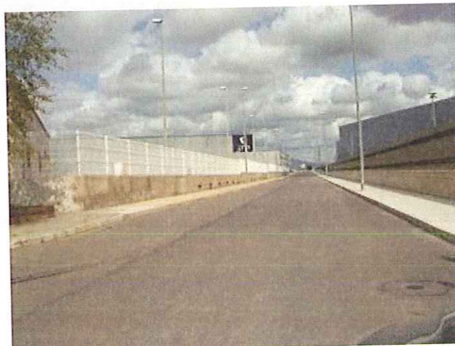
Foto 20: Calle La Vega, sentido calle Torrehermosa.
