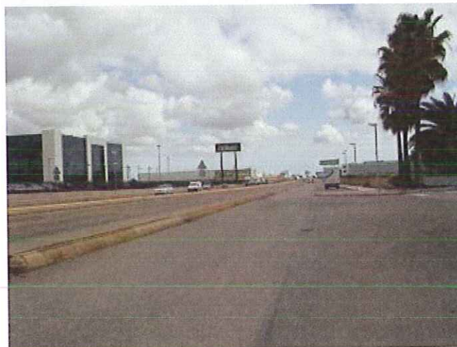
Foto 5: Vial de servicio (pk 1+360 sentido Vila-real)
