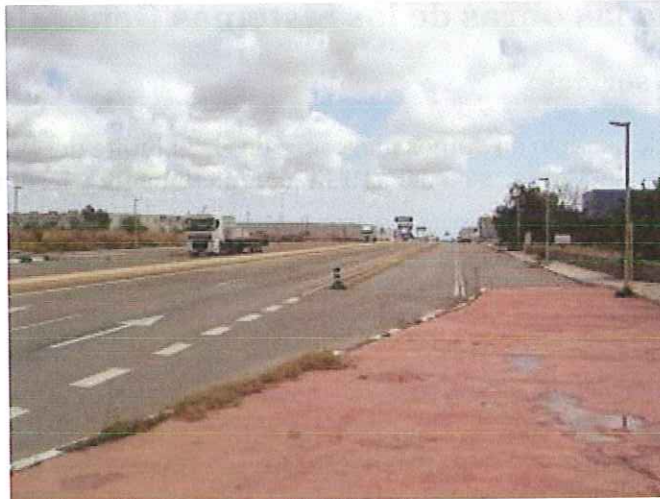
Foto 4: Vial de servicio (pk 0+580 sentido Vila-real)
