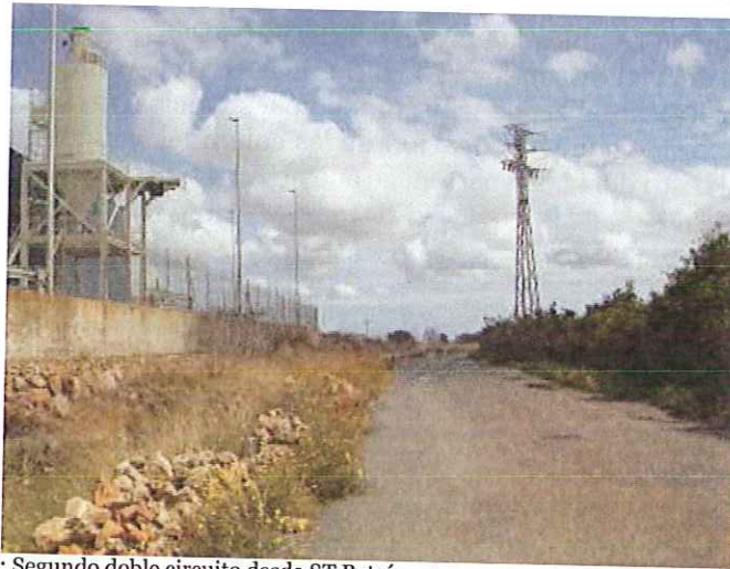
Foto 17: Segundo doble circuito desde ST Betxí.
