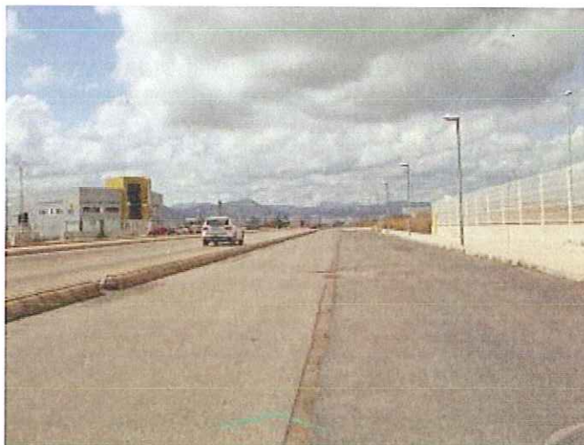
Foto 12: Vial de servicio (pk 1+040 sentido Onda)
