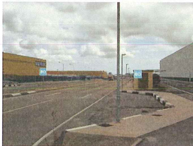
Foto 2: Vial de servicio (pk 0+020 sentido Vila-real)
