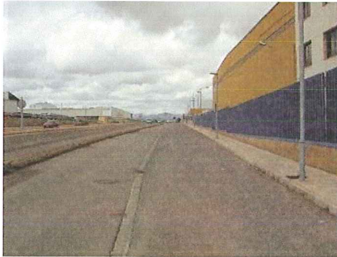
Foto 1: Vial de servicio (pk 0+300 sentido Onda)
