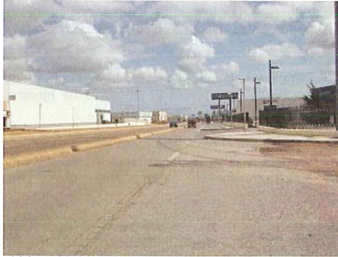
Foto 7: Vial de servicio (pk 2+380 sentido Vila-real)
