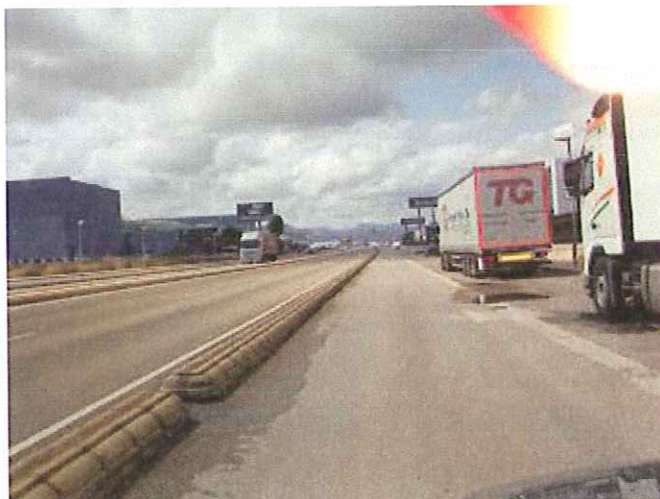
Foto 11: Vial de servicio (pk 1+600 sentido Onda)
