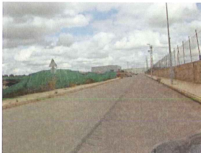
Foto 27: Calle L'Alcoia, sentido CV20.
