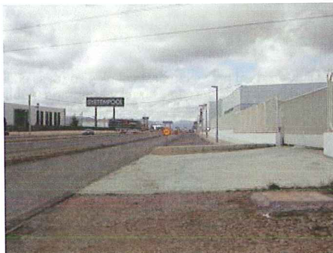
Foto 10: Vial de servicio (pk 2+580 sentido Onda)
