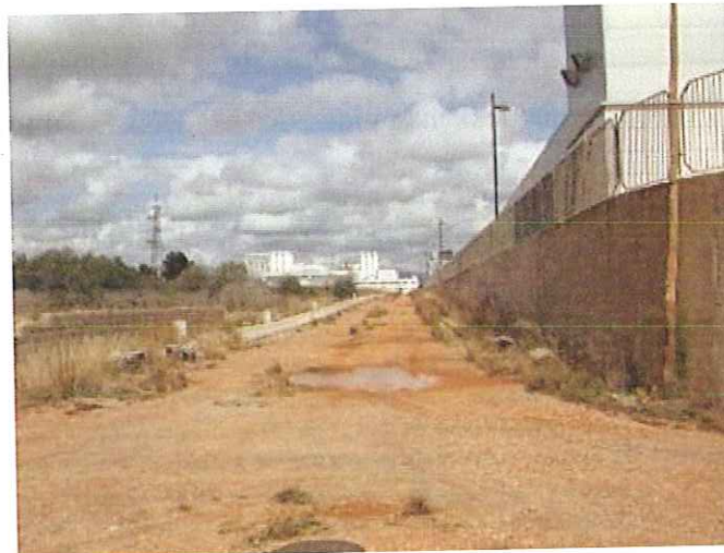
Foto 20: Calle Morvedre, sentido Vial de Servicio.
