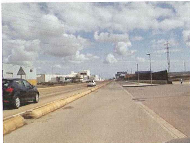
Foto 6: Vial de servicio (pk 1+980 sentido Vila-real)
