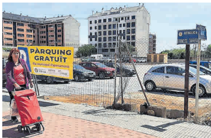
El nuevo aparcamiento entre Francesc Tàrraga y Gloria Fuertes para 60 coches.
