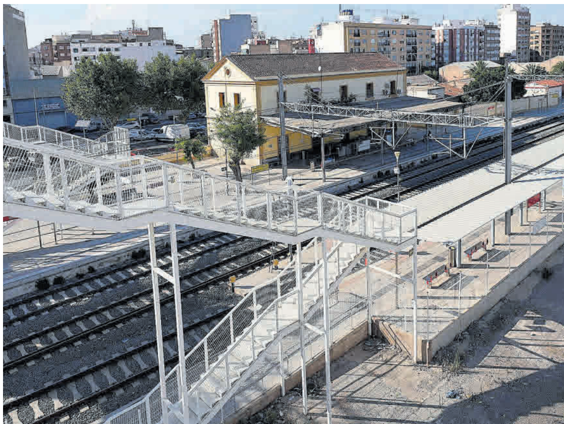
Aquestes són les escales que utilitzen els vianants per a creuar d'un costat a l'altre de la via a l'estació de tren de Vila-real.
