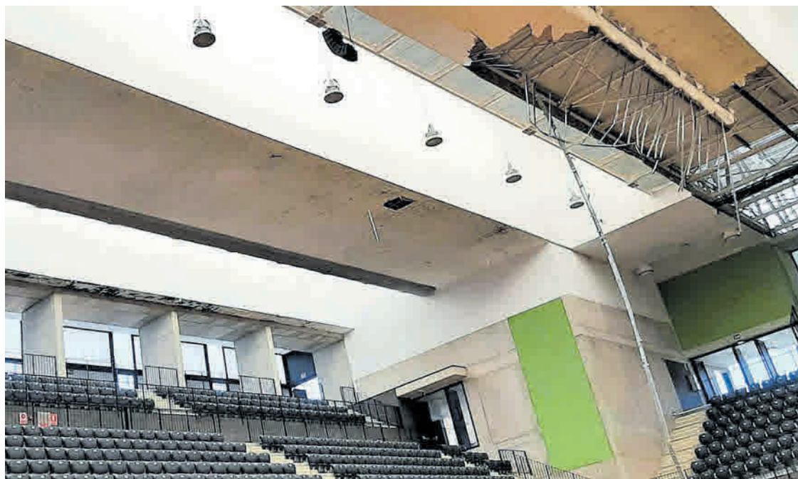
La reparació de la part de la coberta que es va esfondrar sobre les graderies és la primera intervenció que es realitzarà.
