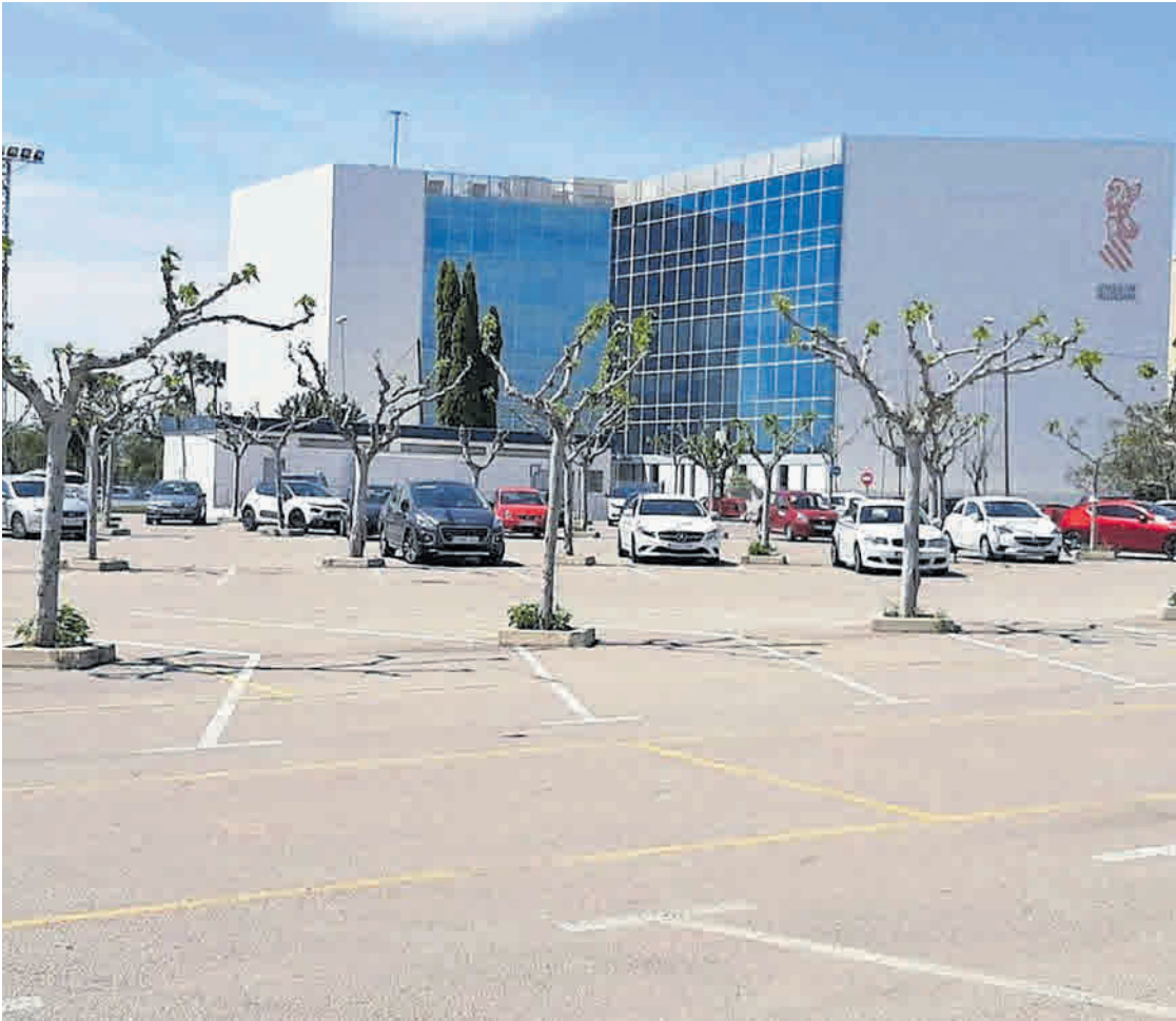
Imagen del parking donde se construirá la nueva comisaría de la Policía Nacional de Vila-real.
