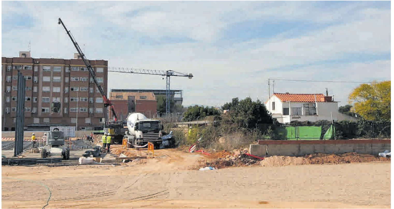
Imatge de febrer del 2011, amb les obres del col·legi públic José Soriano de Vila-real acabades d'iniciar.
