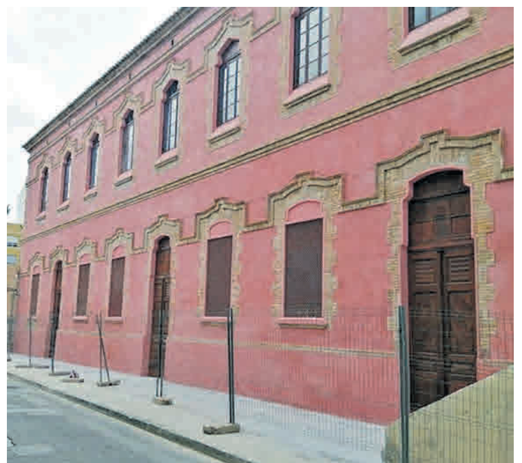
Façana renovada després de l'actuació a l'immoble de l'antic cine Condal.
