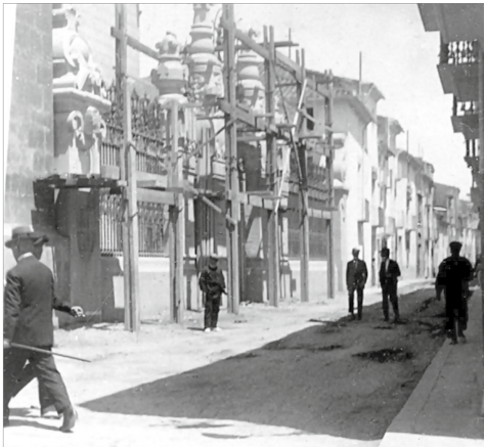
Instal·lació de la reixa a l'església Arxiprestal l'any 1926
