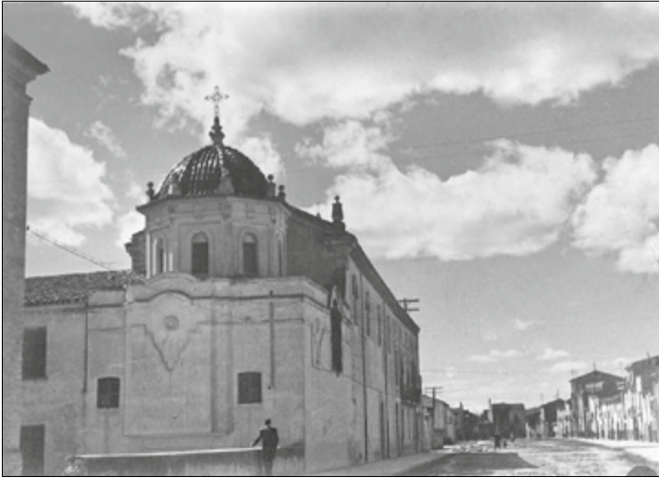
Capella i Hospital amb el pont damunt del Barranquet
