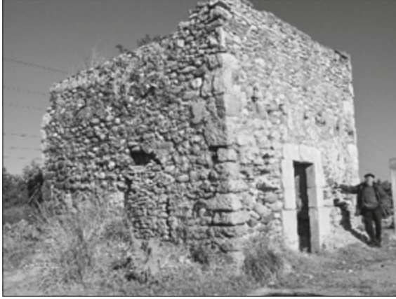
Alquerieta i torre de vigia a l'horta de Vila-real cap a Borriana
