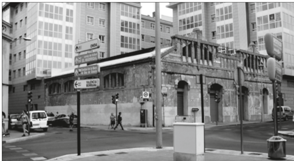
Immoble del carrer de l'Ermida, 159
