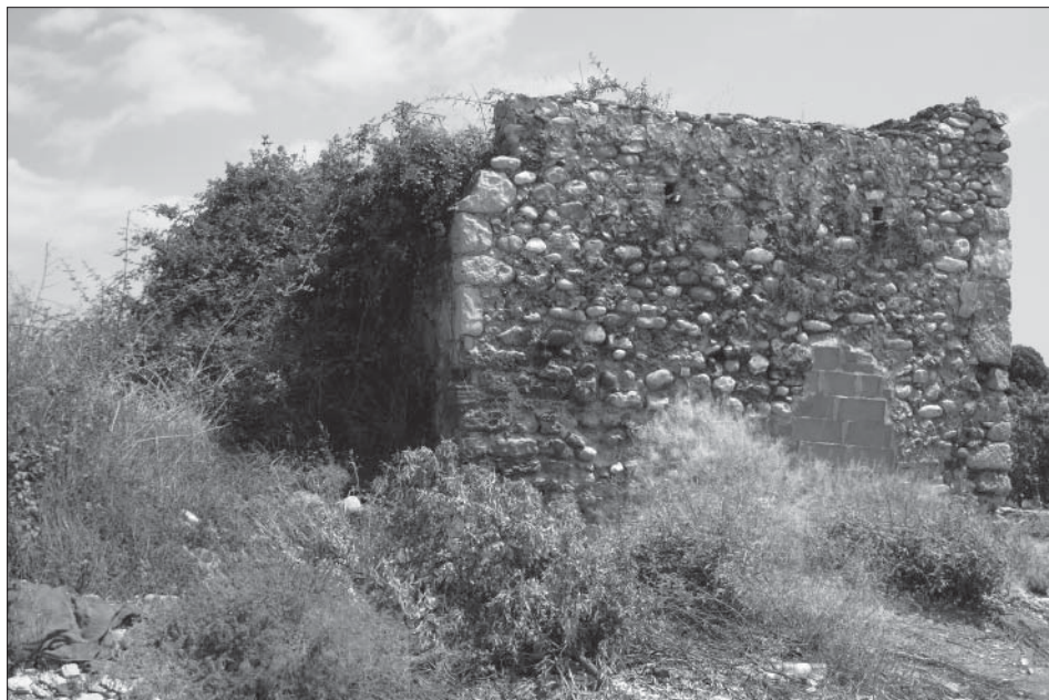
Torre de vigilància del camí de Sant Jordi. Vista des del sud
